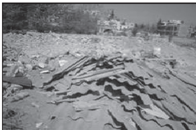
a. Asbestos mats
